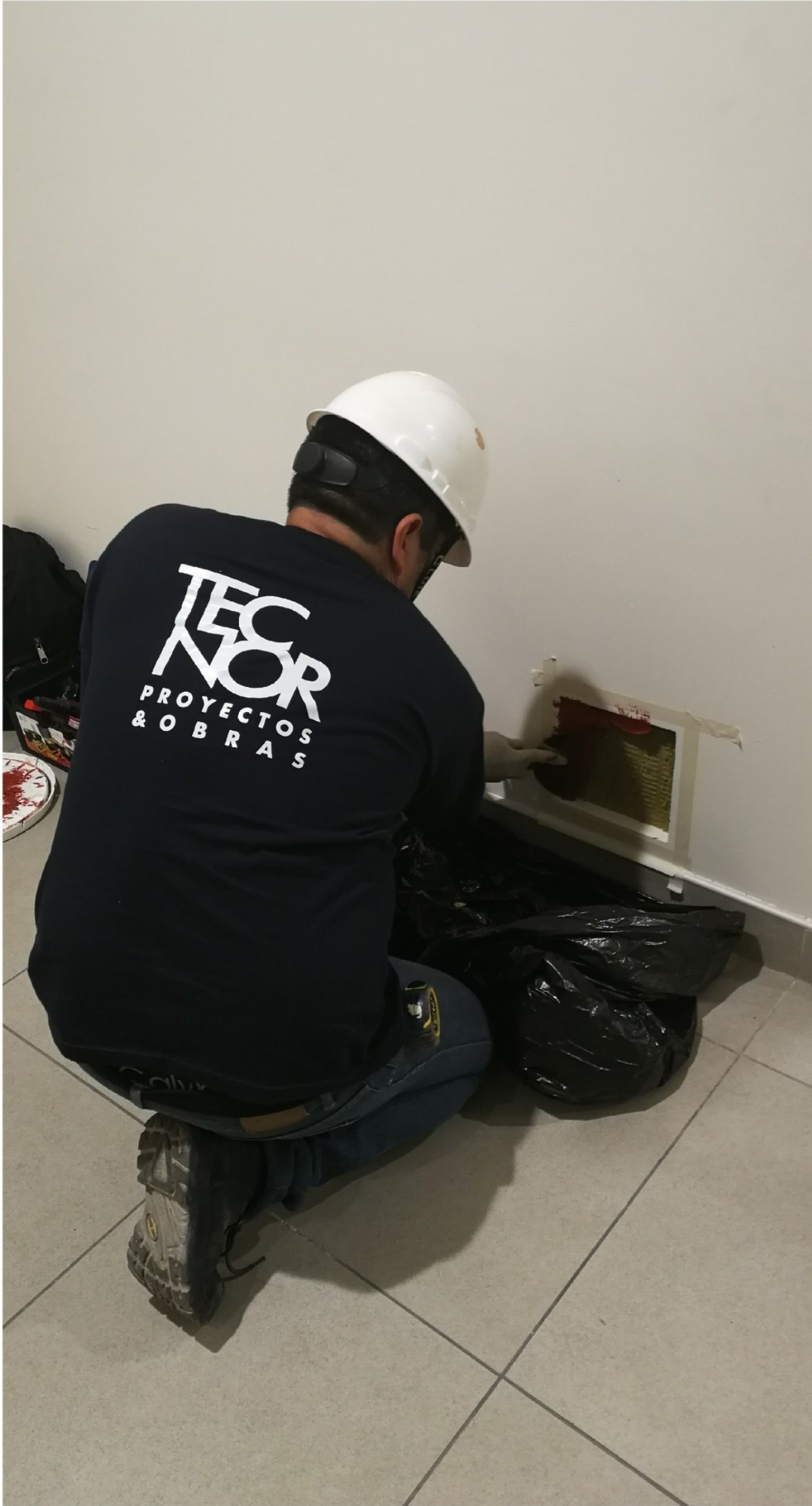
Instalación de Sistemas Cortafuego en escalera de emergencia de la Obra Hotel Ibis Benavides - Miraflores
