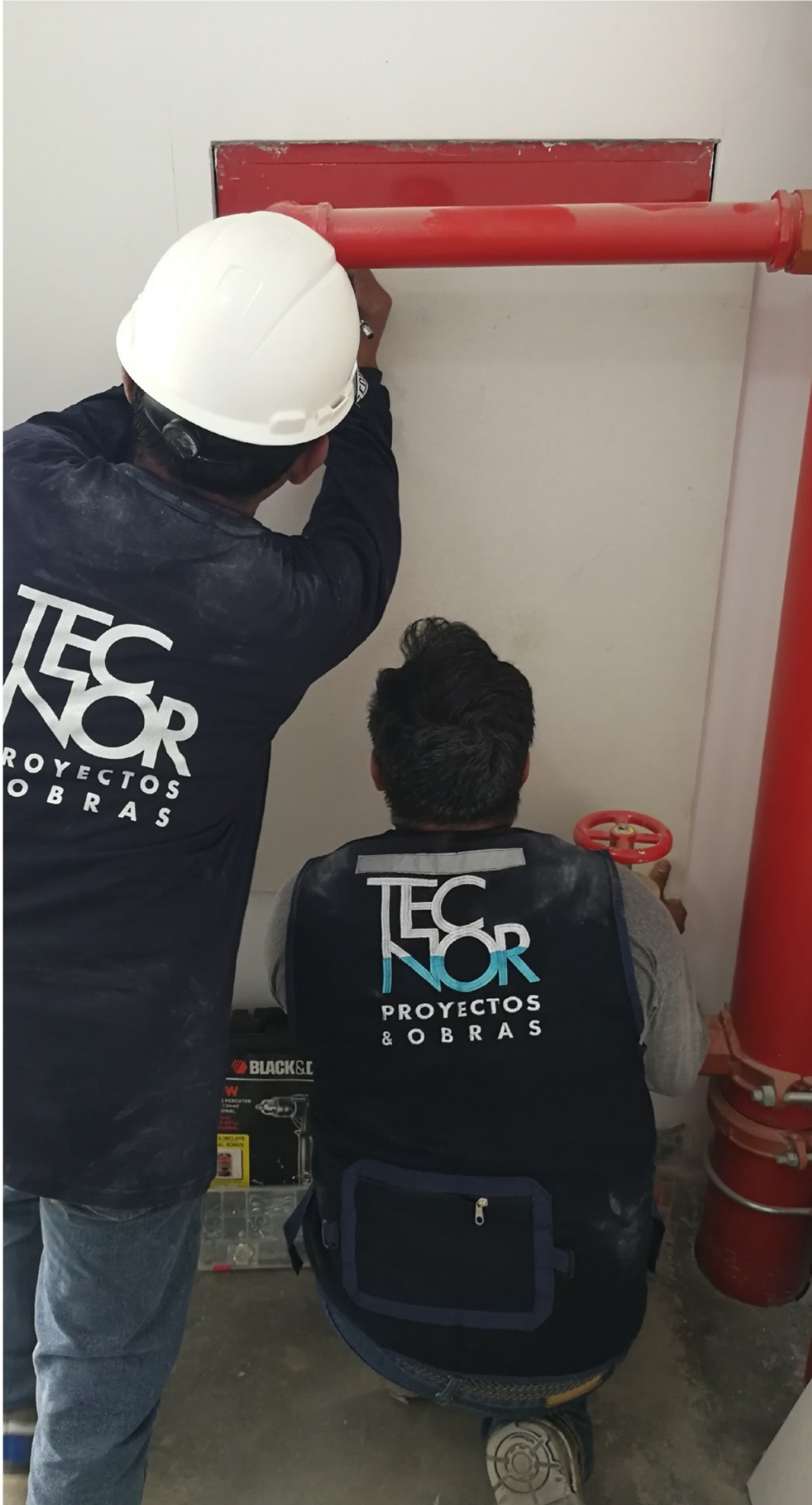
Acondicionamiento Cortafuego de Pases de Manguera de Bomberos en escalera de emergencia del pabellón B de UPC - Salaverry
