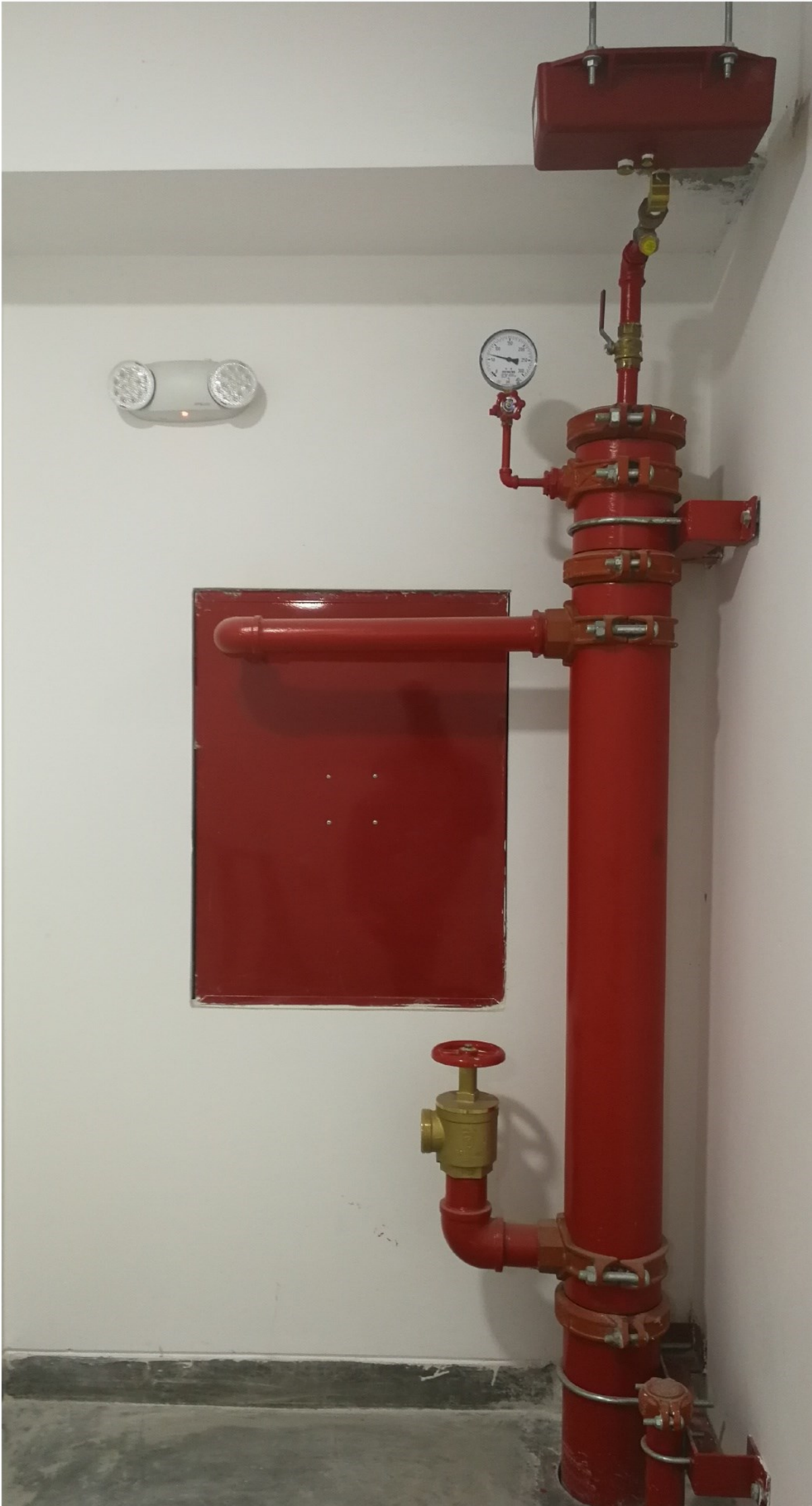
Acondicionamiento Cortafuego de Pases de Manguera de Bomberos en escalera de emergencia del pabellón B de UPC - Salaverry
